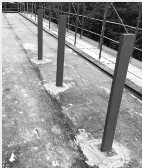
Immagine di cantiere prima dell'installazione di Giuletta
